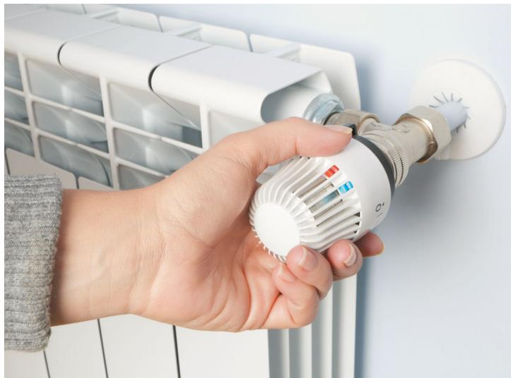
Как известно, термоголовка реагирует на температуру воздуха вокруг неё и соответственно регулирует подачу теплоносителя в радиатор, чтобы удерживать нужную температуру в помещении.
