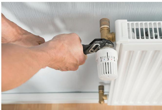
Чтобы снизить эту температуру, термоголовка перекрывает подачу теплоносителя в радиатор и тот остывает. Однако стоит термоголовке запустить теплоноситель, как окружающая температура вновь быстро поднимется и устройству придется в очередной раз «заглушать» радиатор. В итоге, он практически перестает действовать, и температура в помещении уже не поднимается.
